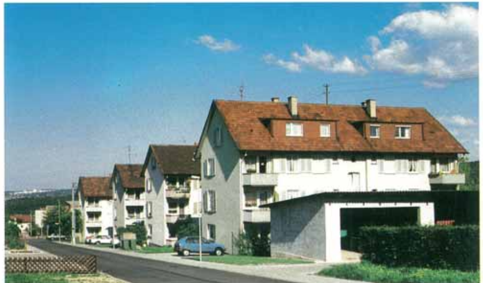
Erster Mietwohnungsbau an der Jahn-/Kirchgartenstraße (1959)
